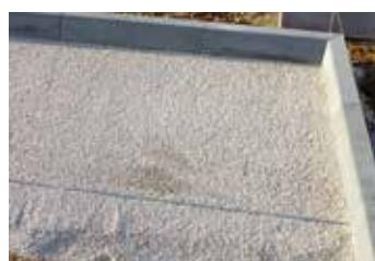
Slijedi faza postavljanja sloja agregata frakcije 4-8mm, debljine sloja 4-5 cm. Agregat se ravna aluminijskom ili drvenom letvom po vodilicama (vodilice definiraju visinu i nagib partera). Kao i planum, radi odvodnje poprečni nagib mora biti 1%. Po poravnatoj površini se ne smije hodati i zbijati dok se ne položi opločnik.
