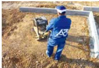
Na mjesto uklonjenog materijala nasipa se tamponski materijal (0-40mm) do kote ugrađenog opločnika (-10 do -12 cm). Za sprečavanje nicanja trave, korova, na tamponski sloj se preferira staviti Geotekstil ili neke druge kemiske preparate. Tamponski sloj se zatim zbijava vibro pločom ili valjkom do potrebnog modula zbijenosti.
