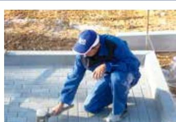
Prije završnog pegljanja opločnika, površinu je potrebno fugirati suhim kvarcnim pijeskom. Pijesak treba u cijelosti umesti , pri čemu zatvaranje fuga treba kontinuirano izvoditi. Nakon toga površina se zbijava vibracijskom pločom koja treba biti obložena gumenom zaštitom. Postupak fugiranja se obavlja još jedanput sa suhim kvarcnim pijeskom i mete s postojećeg partera.
